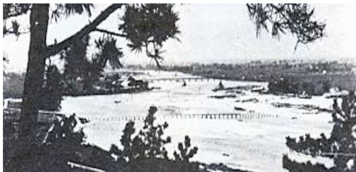
竜泉寺から庄内川・松河戸方面を望む(昭和 8 年頃) 中央に本流のみに架橋された松川橋。奥は中央線(西線)庄内川鉄橋。
