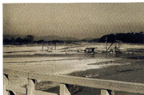
旧木造橋から建設中の現在の橋を見る(写真は昭和35年)
