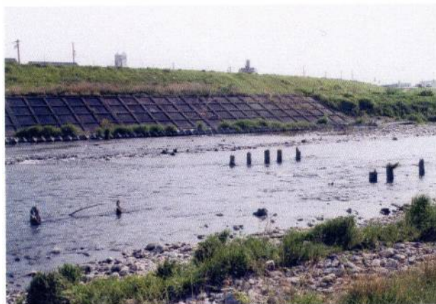
▲平成17年頃 木橋の松河戸橋を取り壊した跡 庄内川に残った橋の杭い柱 令和元年時点でも、2〜3本の杭い柱が僅かにのこっている。
