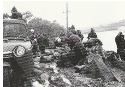
下津の庄内川付近 土のうを積み上げているところ
