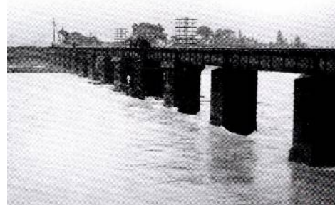
中央線の庄内川橋梁は橋脚の一部が壊れてしまっ た。橋の真ん中辺りに、被害確認か応急修理をして いる人々の姿が見える。 半年間中央線不通
