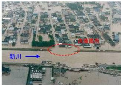
平成12年9月洪水（東海豪雨） 新川決壊地点の状況
