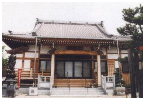
平成20年12月6日に再建された本堂
