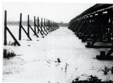
松河戸橋は、昭和 32 年の集中豪雨で大破(松河戸誌研究会)(松河戸側から)
