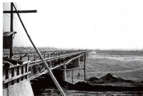
松川橋の建設(写真は昭和 35 年) 昭和 36 年に完成した現在の鉄筋コンクリート製の橋(松川橋)を架ける工事中(松河戸側から)
