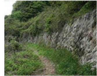
随所に残る玉野街道 土留は谷積の石垣
