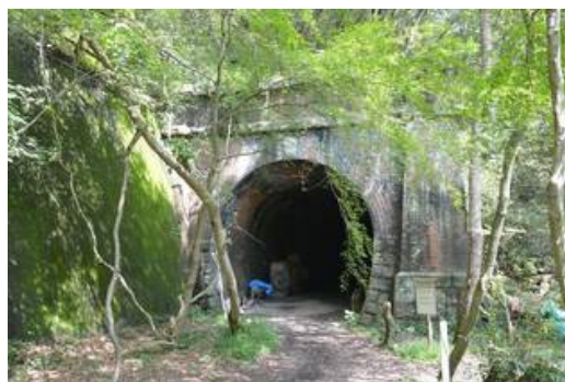
3号トンネル西坑門正面外観(公開前整備中)
