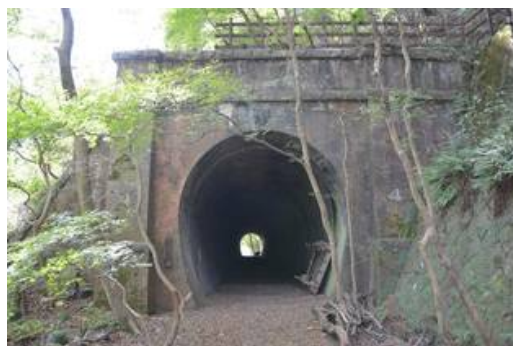
4号トンネル東坑門正面外観(公開前整備中)
