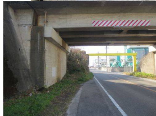
(図1) 奥の旧橋台は歩道を塞いでいる 手前が新橋台で歩道が確保されている。
