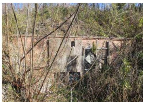
(図3) 旧橋台の奥にあるレンガのトンネル
