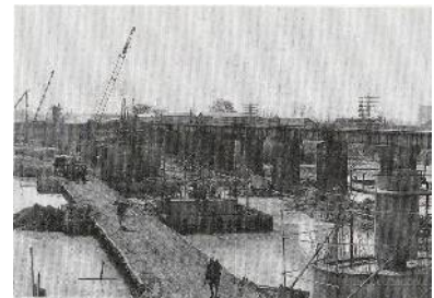
庄内川橋梁 複線化工事(昭和40年)
