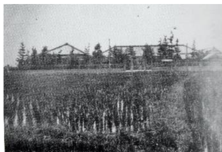
東春日井郡役所 大正2年に勝川駅前通り(字八田山)に移転
