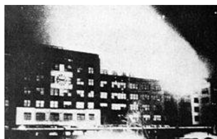
炎上する名古屋駅(昭和20年3月19日) 屋上には高射砲の陣地があったが、敵機には全く届かなかった。
