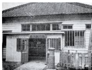
大正 2 年 7 月に勝川町東八田山に新築された勝川郵便局
