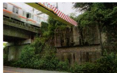
現在に残る字西切野の庄内川橋梁跡 (奥に現在の路線が見える)
