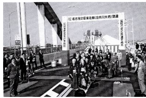
環状2号線の庄内川大橋の開通式(平成6年10月) 写真は、勝川～名古屋守山区喜多山の庄内川大橋区間の開通式の様子。
