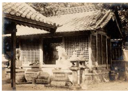
切り妻の平入の旧幣殿(祭文殿) 大正7年に設置された狛犬がみえる。写真は、大正7年～昭和5年
