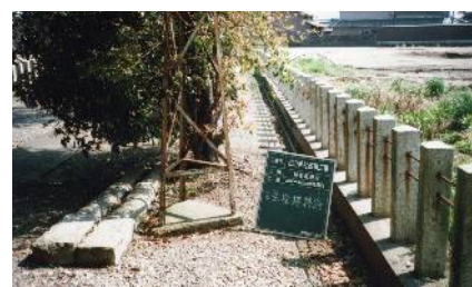
⑥小野社用門柱 ⑨日章旗掲揚塔
