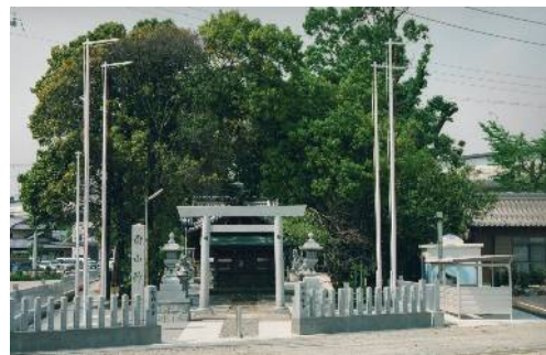
平成 23 年 3 月 改修工事完了 5 月の完成奉告祭前
