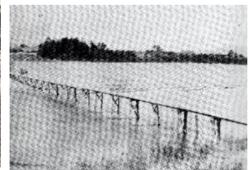
大正13年に本流部分に架けられた木造の橋 この橋が架けられるまで、大日の渡しがあった。
