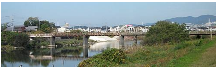
昭和 39 年に造られた大留橋 左岸下流から (平成 10 年)
