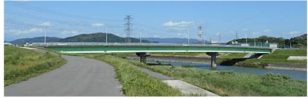
志段味橋 左岸下流から (令和 2 年)
