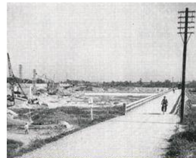
旧勝川橋と建造中の勝川橋 (昭和 29 年)
