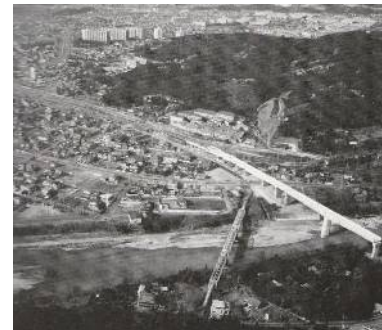
庄内川橋橋梁(愛知環状鉄道)
