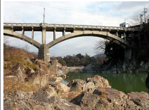
鉄筋コンクリートで被覆された鹿乗橋
