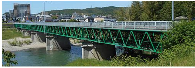
美しいデッキトラス工法の橋 左岸下流から (令和 2 年)
