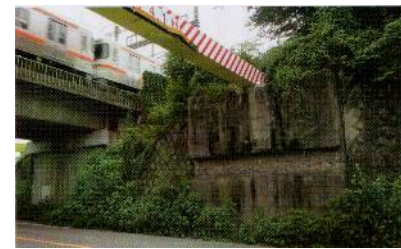
現在に残る字西切野の庄内川橋梁跡 (奥に現在の路線が見える)
