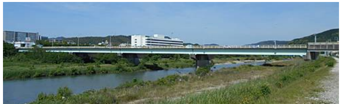
新東谷橋 左岸下流から (令和 2 年)
