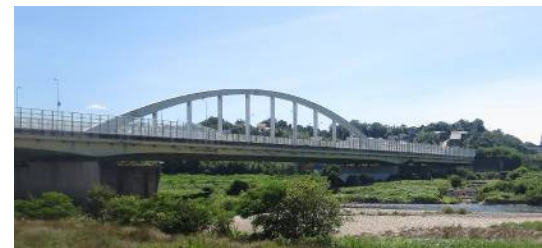
庄内川橋(名古屋第二環状自動車道)(右岸下流から) (令和 2 年)
