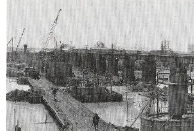
庄内川橋梁 複線化工事(昭和 40 年)
