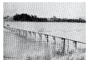
大正 13 年に本流部分に架けられた木造の橋 この橋が架けられるまで、大日の渡しがあった。
