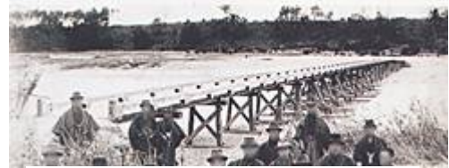
本流部分のみに架けられた旧橋 大正 15 年 上志段味誌
