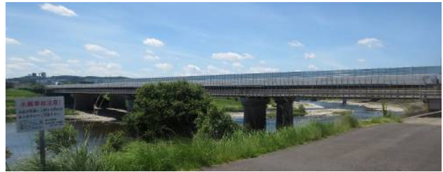
下志段味橋上流約 180m 程にある東名高速道路庄内川橋 右岸上流から(令和 2 年)
