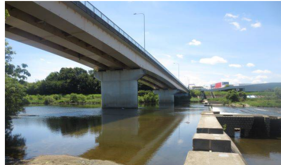
上条用水取水堰 左は吉根橋（右岸から）
