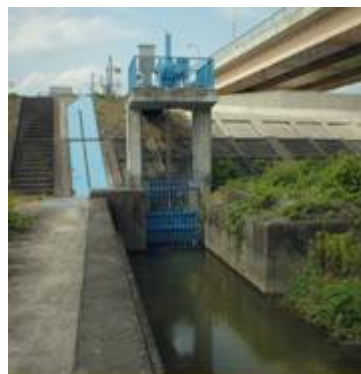
写真 2 取水元杓樋門
