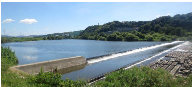
中切の堰堤（写真令和4年3月）
