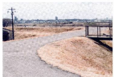
▲平成 8 年頃 くいちがい堤防 余所の地区では見られませんが中切に 1ヶ所、松河戸は東西に 1ヶ所ずつあった。ここには大きな排水門があり、庄内川の水が増えると自動で門が閉り水は入らない。庄内川の水が引くと自動で門が開き部落内の水が流れでる。
