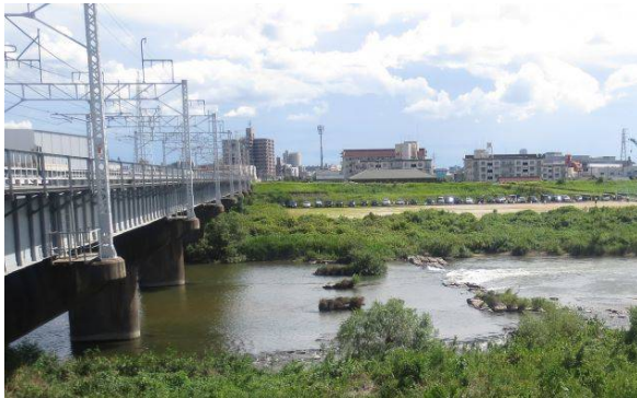
複線化前の橋梁跡（写真令和4年3月） 左に見える現在の中央線橋梁下流下の床止めに利用 中央線橋梁下の床土が流出しないようにするためのもの
