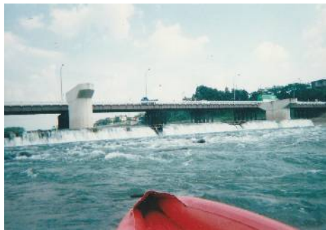
上条用水取水堰 下流から
