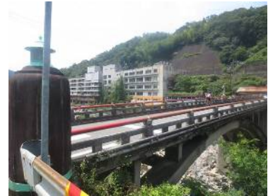
県道205号はこの城嶺橋を渡り左へ廃墟となった千歳楼が見える
