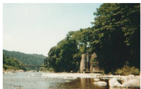
右が玉野水力発電所、奥が玉野橋
