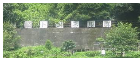
愛岐トンネル群の看板
