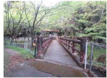
白山橋の下にはうぐい川の清流が流れている。 この橋を渡ると拝殿に着く
