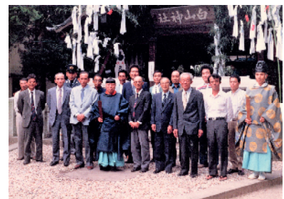
旧白山神社 社殿 解体清祓い時
