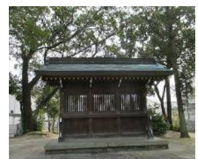
旧手水舎 写真は令和 4 年
