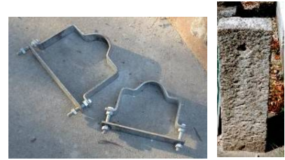
木製の幟棒時代 締め具(固定具) 台座石
