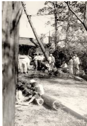
不浄除の右側辺り
