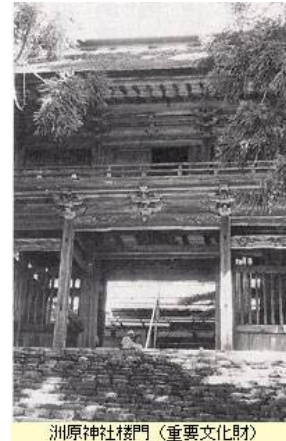
洲原神社楼門(重要文化財)
